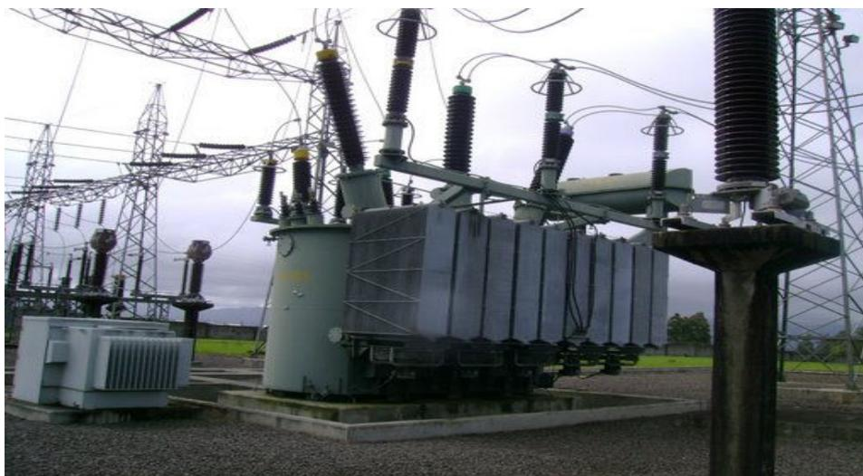
**Figura 2.1 Transformador de potencia sumergido en aceite**
